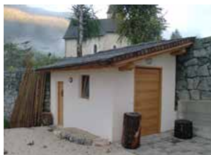
Die neuen Toiletten
