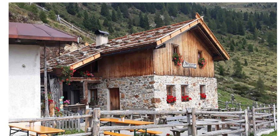
Neues Dach der Stierbergalm
